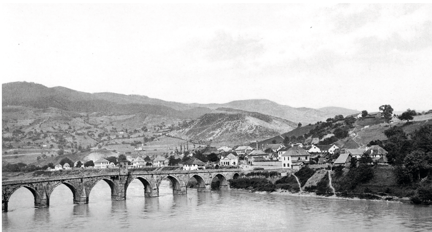
Bild: Anonym, Mehmed Pasa Sokolovic Brücke, Višegrad um 1900.
